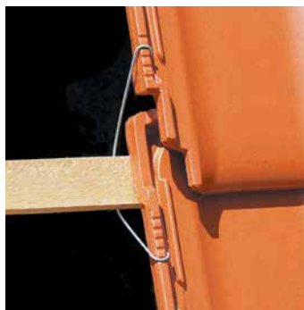
Die Fixierungskerben für die Sturmklammern.
