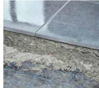
Beispiel für einen Bodenaufbau im Verbund.
