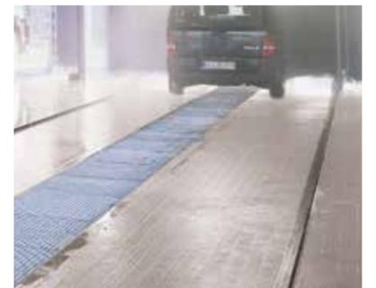
Röben Feinsteinzeug ist trittsicher und rutschfest. Für Arbeitsräume mit erhöhter Rutschgefahr gibt es besonders rutschhemmende Sicherheitsprofile.
