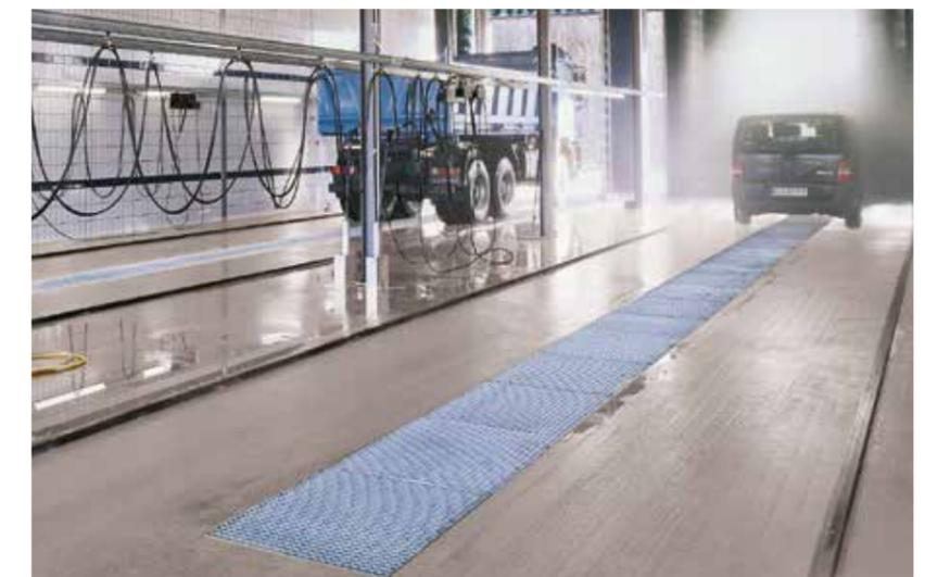
Bei pastösen oder faserig zähen gleitfördernden Stoffen auf dem Boden, z.B. Fett oder Fleisch, kann es dazu kommen, dass der Schuh beim Gehen nicht in ausreichendem Maße Bodenkontakt bekommt, weil der gleitfördernde Stoff an der Auftrittstelle als geschlossene Schicht über der Bodenfläche verbleibt. Das Zusammenwirken verschiedener gleitfördernder Stoffe, z.B. Fett und Wasser, kann die Rutschgefahr erhöhen.
